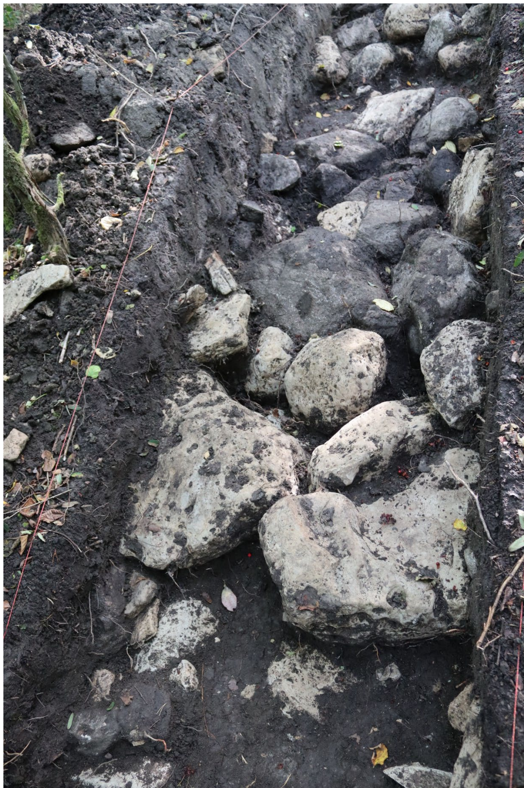
Foto 83. N-müür, vaade NW-poolt, II kiht.
